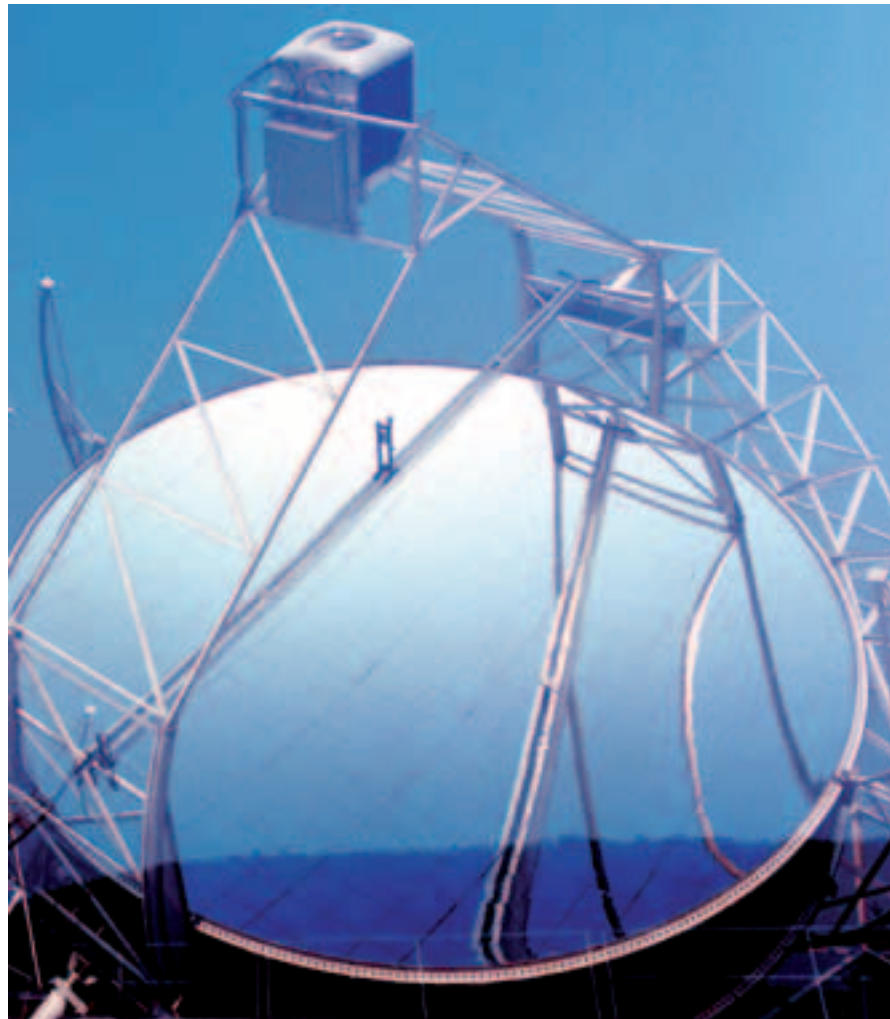
Parabolspiegel aus Edelstahl, Forschungsanlage in Almeria, Spanien*
